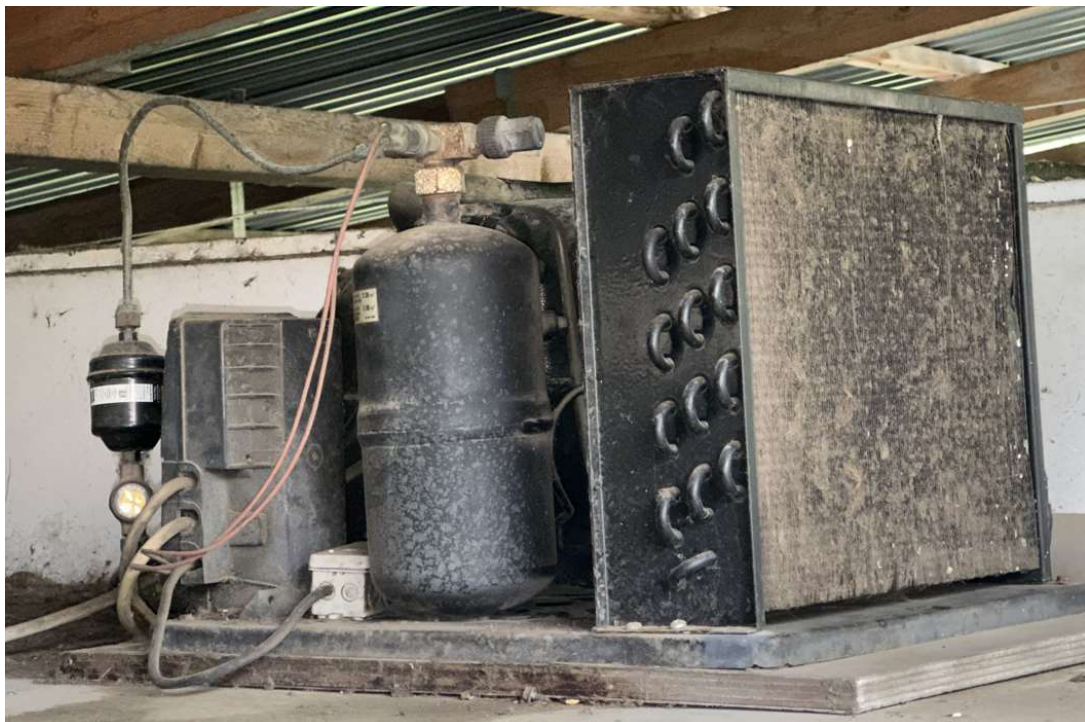
Abbildung 22: Verbaute Tiefkühlanlage
