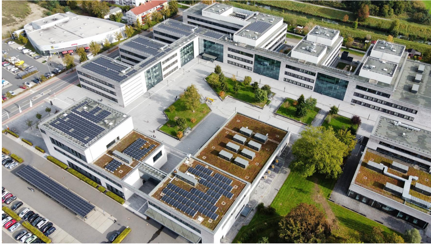
Solaranlage Hochschule Hamm Lippstadt – 459 kWp mit 1119 Modulen
